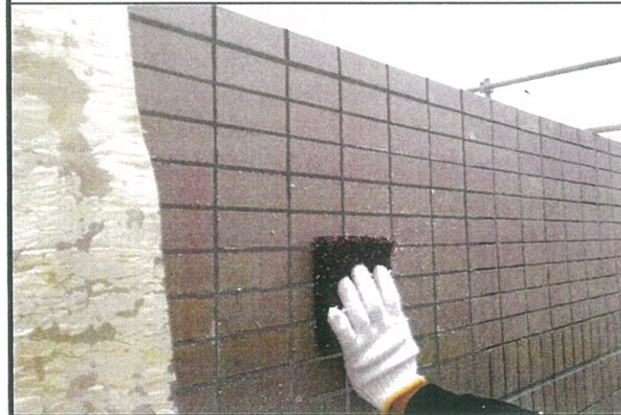
⑩除去作業で最終的に残ったプライマー表面を スコッチにて目粗しする。
