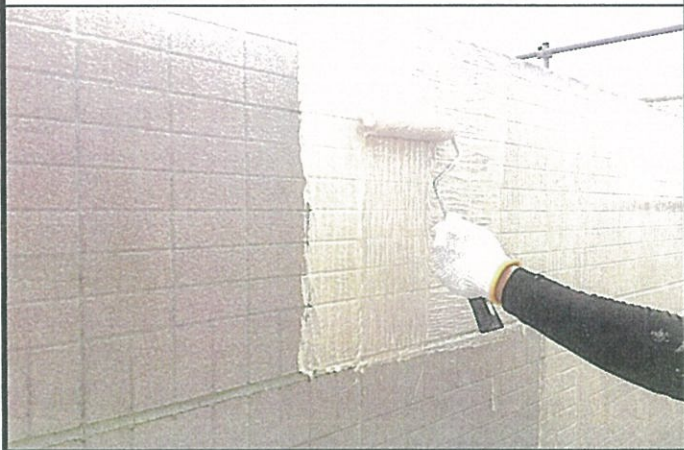
②プラチナZをループローラーで1.0kg/㎡以上塗布する。 ※塗布量が規定量に満たない場合、 旧塗膜が軟化しきれない場合があります。
