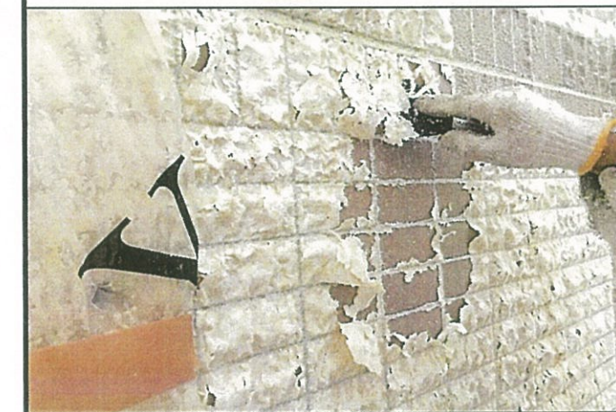
⑧その後、残存塗膜を※カーボンヘラで剥がしていく。 タイル面に限り金属ヘラは使用しない事。 (タイル表面が黒ずんでしまう為)
