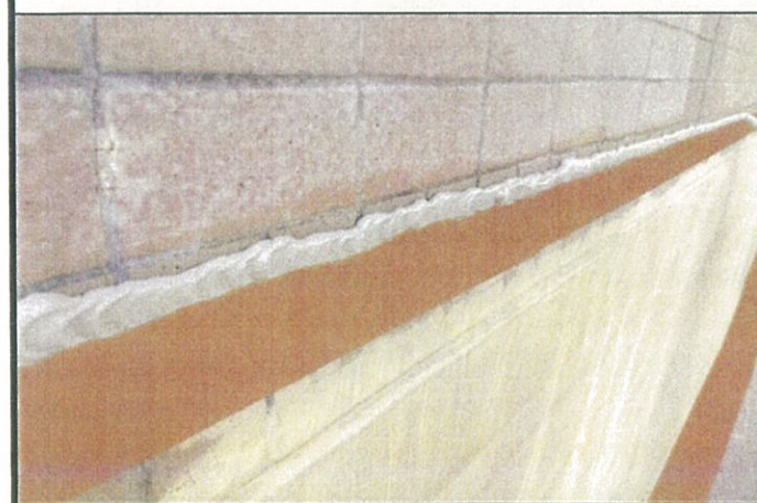
⑤ラッピング部の最上部に剥離シールを打つ(雨養生) ※そのまま72~168時間程度放置する。
