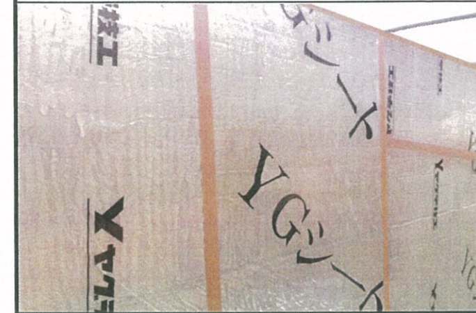
④ラッピングしたらガムテープ(50mm幅)で YGシートの重ね部を全て貼り合わせる。 (雨水、風が入り込まないようにする為)
