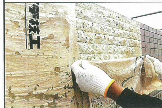
⑦YGシートをゆっくり剥がしていく。 (旧塗膜の劣化度によってシートに転写されて 一緒に剥がれる場合がある)
