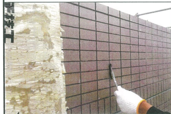
⑨目地の残存塗膜はカッターとワイヤーブラシで除去する。
