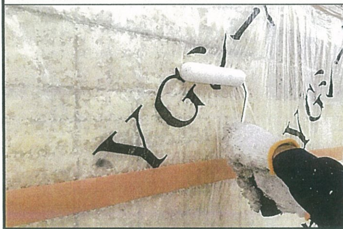
⑥放置後スモールウールローラーで 力を入れてYGシート表面を転圧する。
